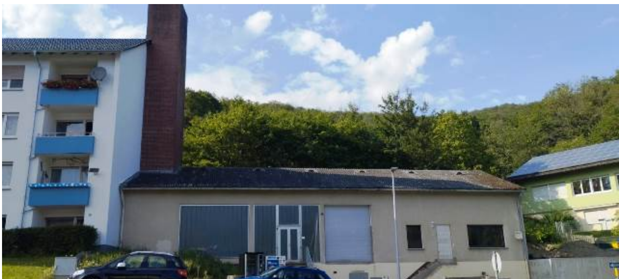
Best. Gebäude Straßenansicht – mit Nachbarbebauung
