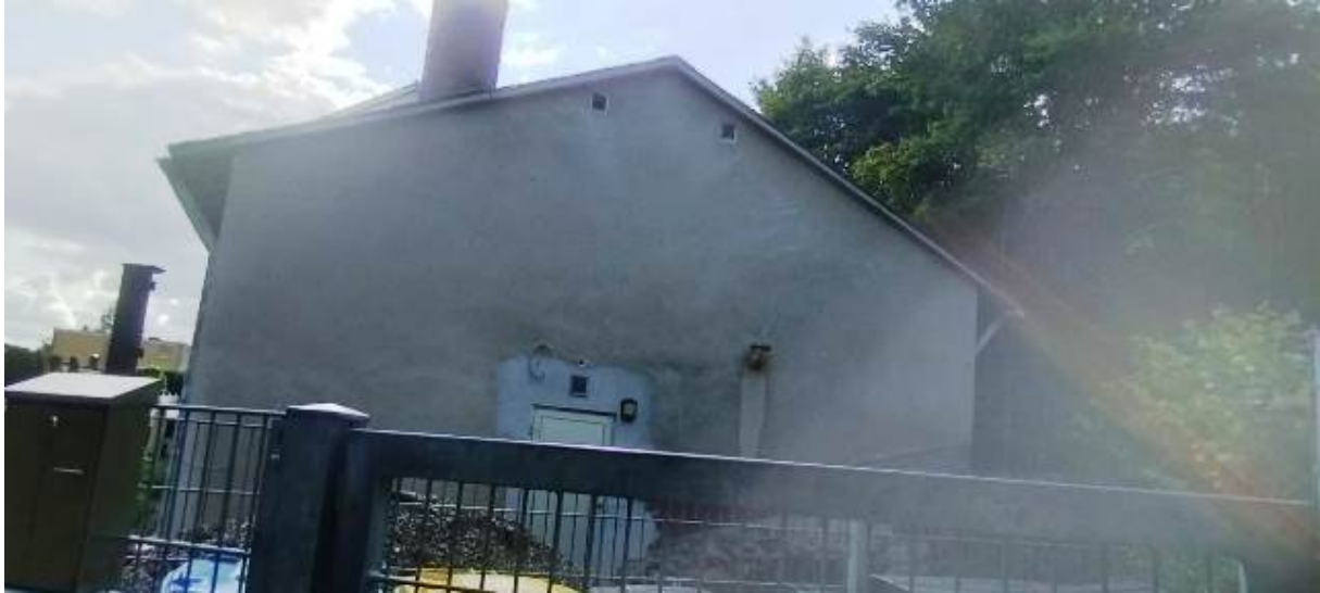
Best. Gebäude – Ansicht Ost
